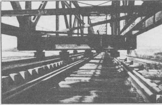
Fig. 496. Voie de lançage du pont de service, entretoises et galets de roulement.
