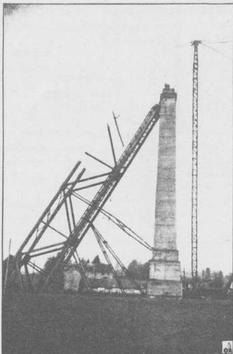
**Fig. 488.** Démontage de la travée n° 17 à l'aide du mât de 54 mètres.
