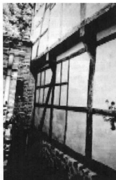
gerestaureerde noordgevel Anno 2000
