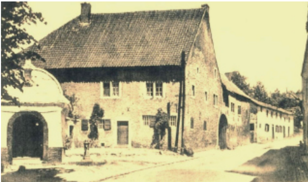
Herberg De Swaen in 1949. Links is nog net de oude dorpslinde zichtbaar. De oostgevel is nog in originele staat. Deze is rond 1965 na een instorting gesloopt en is nooit meer opgebouwd. In de 18 de eeuw was de westbouw er nog niet, zodat de opening naar de cour nu omgekeerd is. Fotograaf onbekend.
