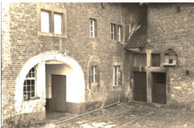
De cour van De Swaen in 1971 met achteringang van de herberg. Er is nog niets gerestaureerd. In de ongeschonden binnenruimten lijkt alles nog zo te zijn als in vroeger tijden. Foto Ed de Grood.
